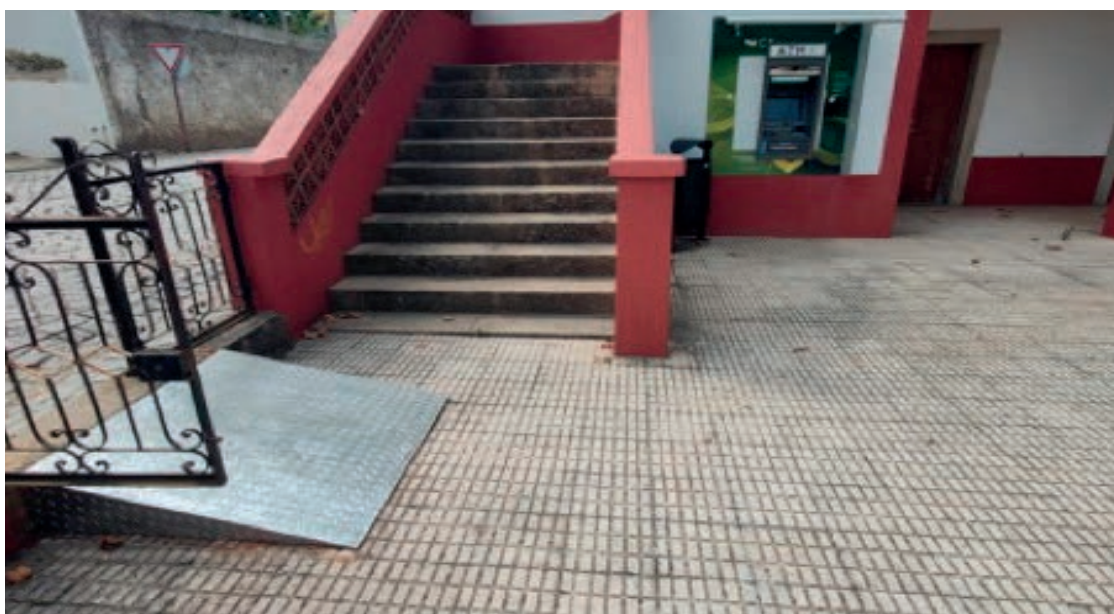
Extensão de Soto da Casa Rampa de acesso ao ATM e escadaria de acesso
